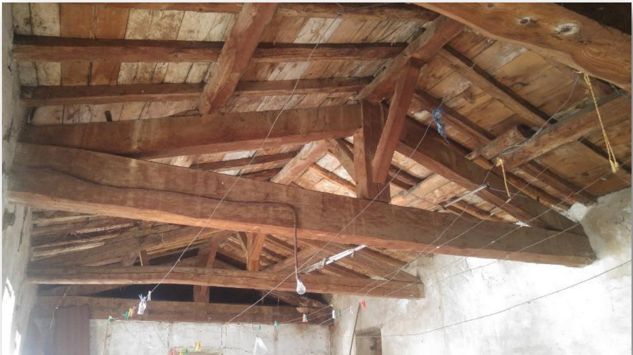
Bâtiment Est, 1 er étage
