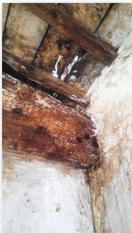
2017 et 2020 (En 3 ans la poutre a lâché le mur et ne repose plus que sur la fragile cloison !)
